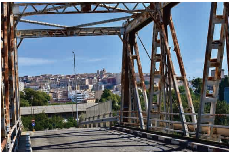
12. Il vecchio ponte di ferro presso la località della Scaffa alle porte di Cagliari (2019).
