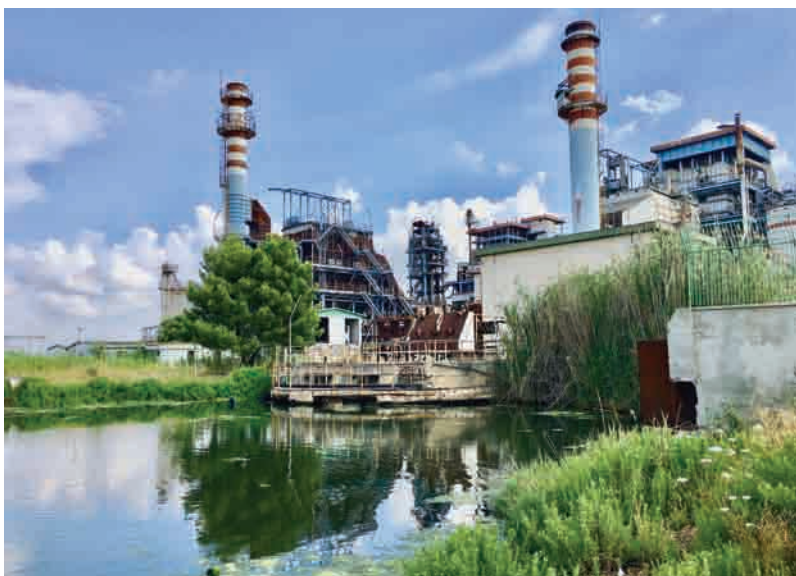
9. La centrale elettrica abbandonata alla periferia di Cagliari sulla riva nord-ovest della laguna (2019).
